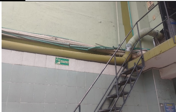
Foto No. 6 Tubería de circulación de agua lluvia al predio
