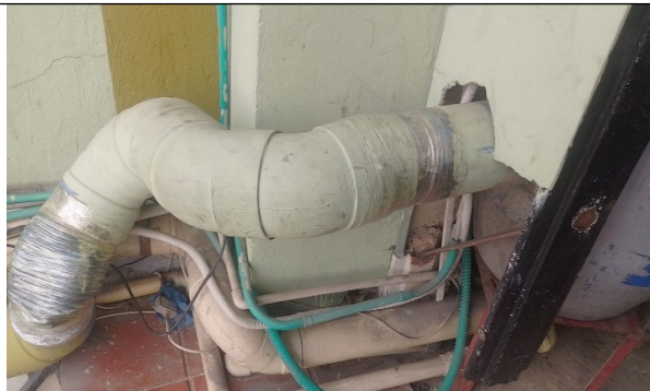
Foto No. 5 Tubería de circulación de agua lluvia
